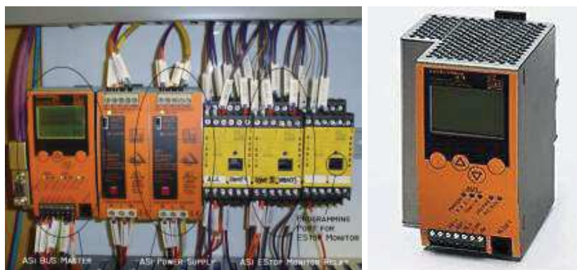
Obr. 3 Ovládač, napájacie zdroje, bezpečnostný monitor a AS-i Riadiaca jednotka
